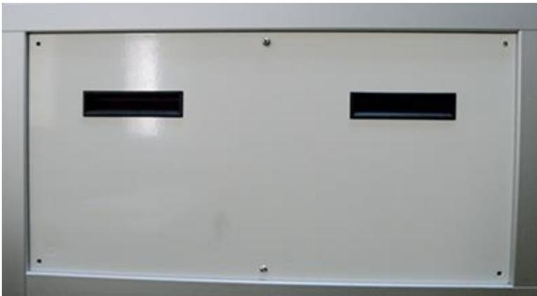
Abrir o painel lateral desapertando os parafusos necessários (2, máx. 6)
