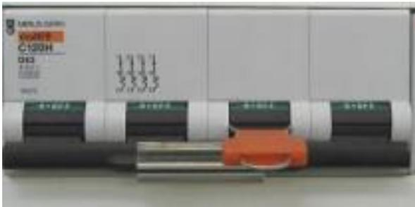
Na parte de trás do RTA desligar o "GENERAL CIRCUIT BREAKER" ao colocá-lo na posição ilustrada ao lado (para baixo)!
