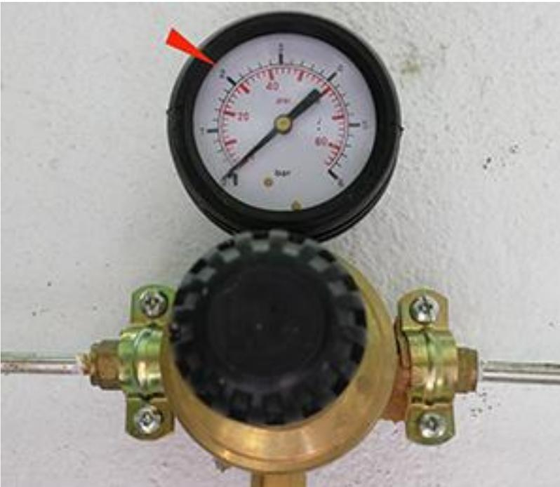
Abrir o reductor da linha de N2 até aos 2 bar de pressão ou até um valor ligeiramente superior! (Rodar o parafuso no sentido dos ponteiros do relógio). O manómetro de linha deverá indicar 2 bar de pressão ou ligeiramente superior!
