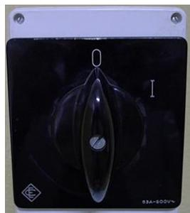
Desligar o interruptor da alimentação, na parede, rodar para a posição 0.
