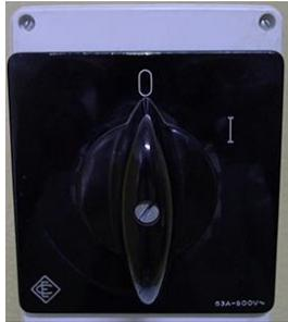
Ligar o interruptor da alimentação, na parede, rodar para a posição I.
